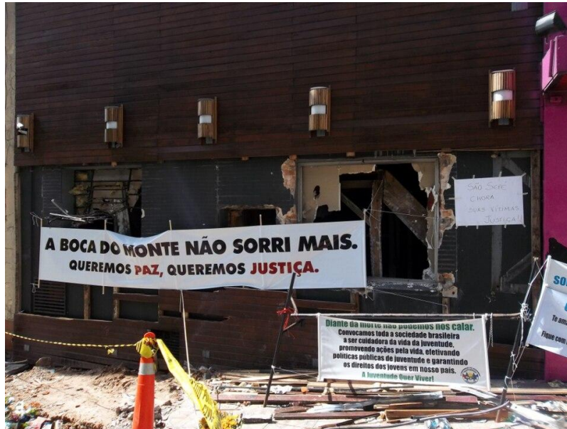
Fachada de la discoteca Kiss días después del incendio. Foto: Leandro LV, CC BY-SA 3.0, vía Wikimedia Commons.
