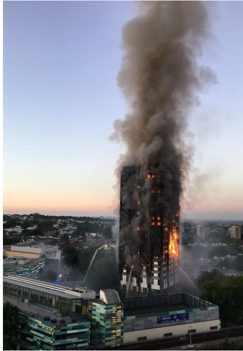
La Torre Grenfell en llamas, 14 de junio de 2017. Foto: Natalie Oxford, CC BY 4.0, vía Wikimedia Commons.
