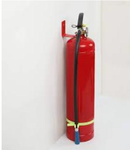
Fijados de manera segura a un gancho previsto para el extintor.
