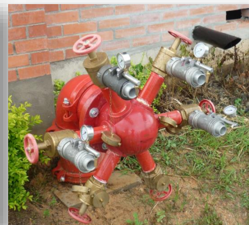
CABEZAL DE PRUEBAS Y VALVULAS DE MANGUERA
