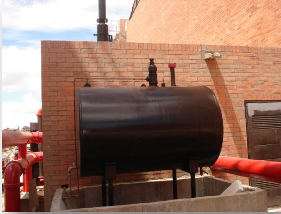
TANQUE DE COMBUSTIBLE
