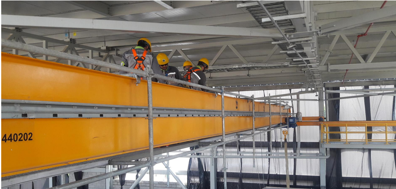
Equipos para trabajo en alturas
