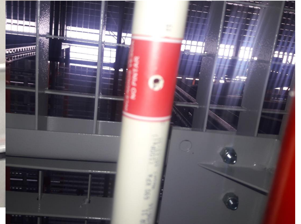
Etiquetar todos los orificios de la tubería CPVC
